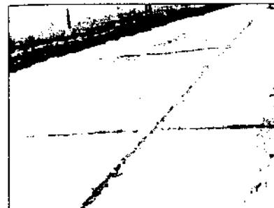
**Fig. 3.6. Rosturi cu mastic în exces**
