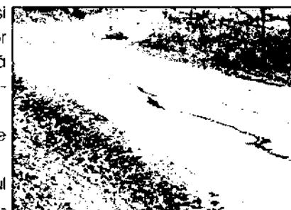
Fig. 3.9. Fisuri longitudinale
