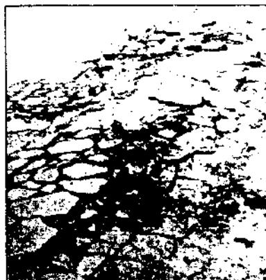
Fig. 2.19. Degrădări din îngheț-dezghet
